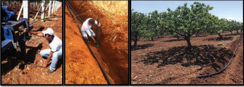
Şekil 4. Yüzeyaltı damla sulama lateralinin tesisi
