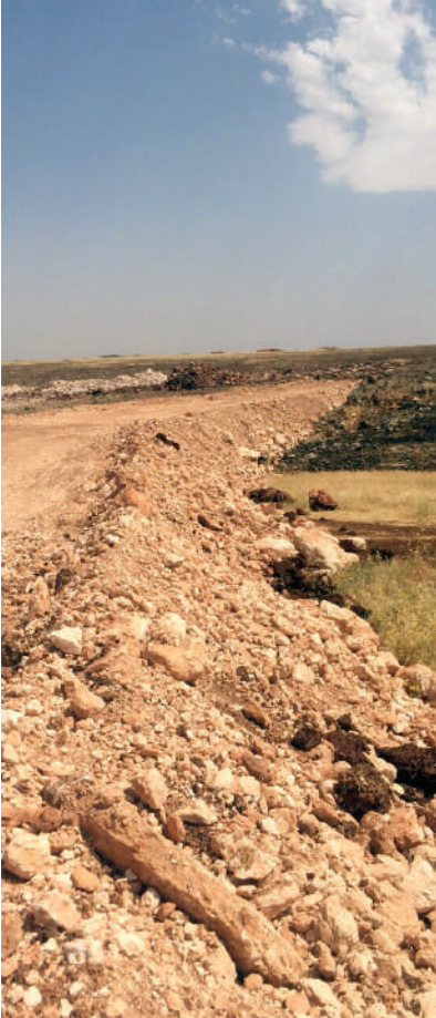
Yol yapım çalışmaları tüm hızıyla sürüyor.
